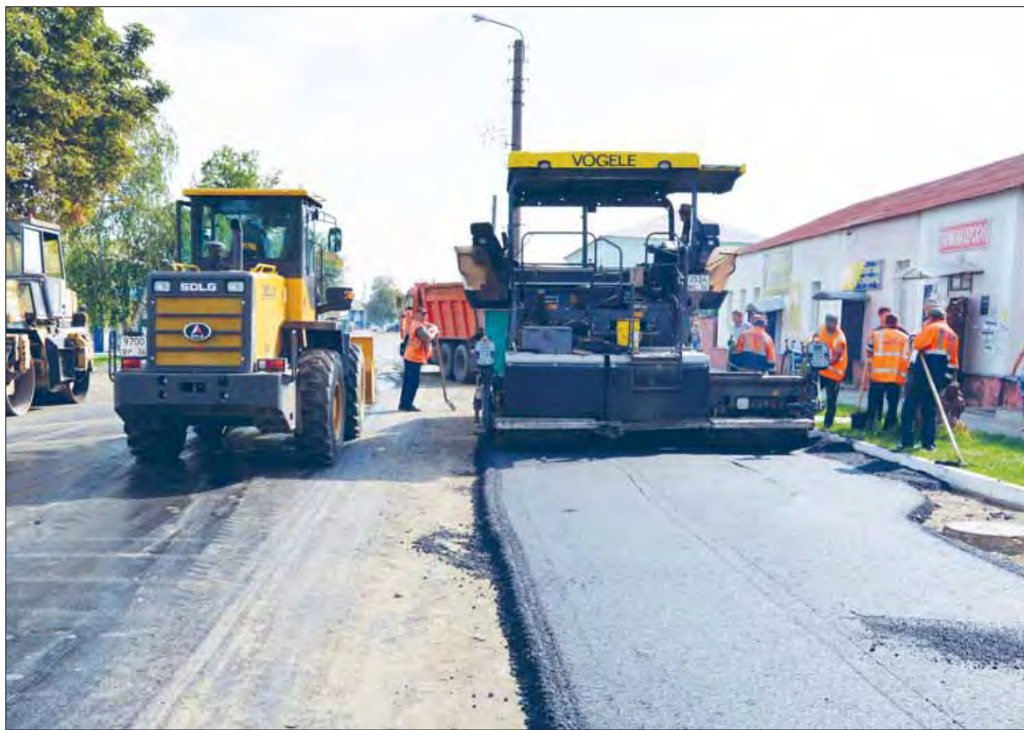
Работы идут полным ходом.
